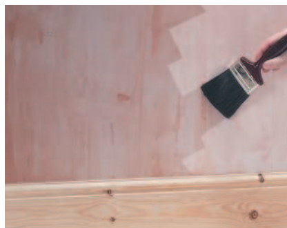
Новую штукатурку покройте щелочестойкой грунтовкой
