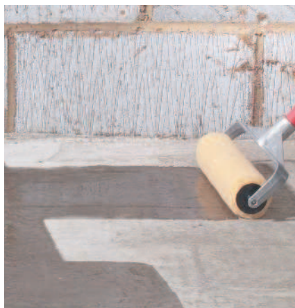
Пористый бетон обработайте герметизирующим составом
